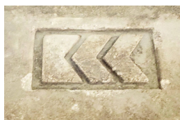
Рис. 8 Логотип компании КСС на корпусах железобетонных колодцев.
